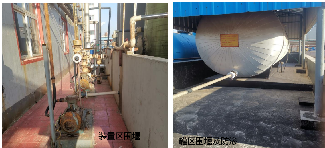
图 3.2-2 装置区及罐区的围堰及防渗情况
