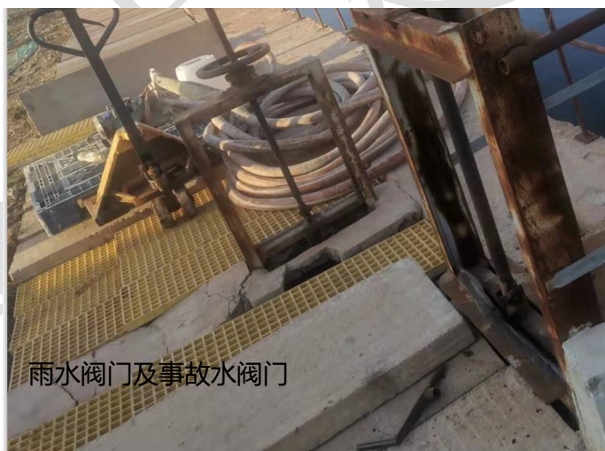
图 3.2-3 厂区三级防控阀门设置情况
