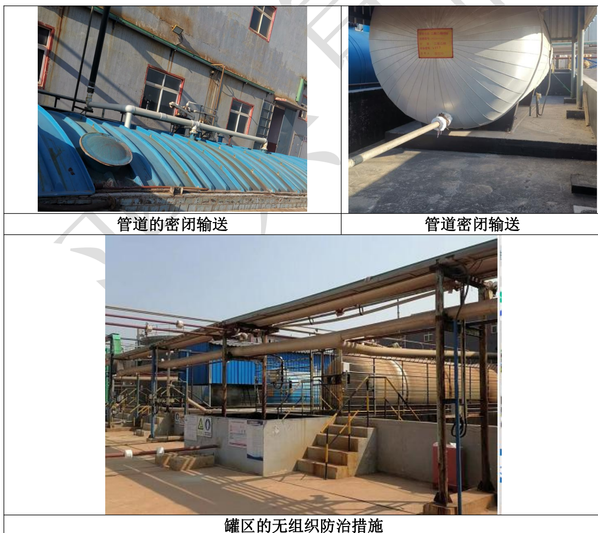
图 3.1-11 无组织废气处理设施建设现状情况
