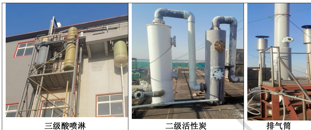
图 3.1-7 溶剂法铜酞菁车间缩合废气、有机废气处理设施现状建设图
